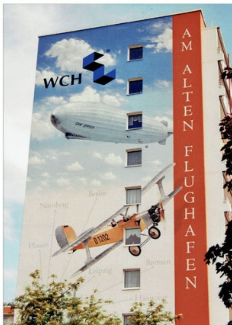
Ansicht Hausfassade Straße Usti nad Labem
